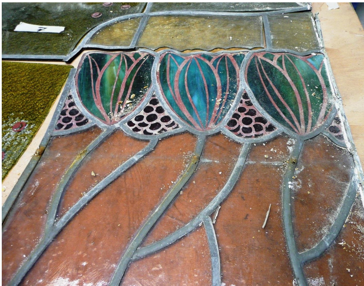
In het kader van vooronderzoek uitgenomen glas-in-loodpaneel. Na voorzichtige ontmanteling wordt de staat van het loodskelet en de dichting tussen glas en lood gezien.
